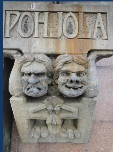
Здание страховой компании «Похьола». Гизелиус – Линдгрэн – Сааринен. Aleksanterinkatu, 44 – Mikonkatu 3. 1899-1901
