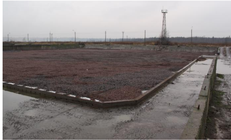
Подготовленный дренаж для укладки геотуб
