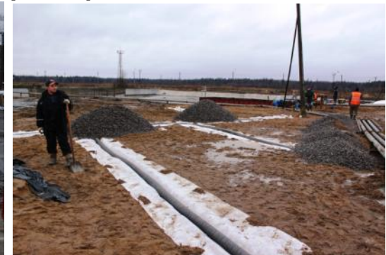
Подготовка дренажной системы для полного сбора и отвода фильтрата
