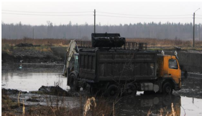
Очистка иловых карт от осадка для размещения геотуб
