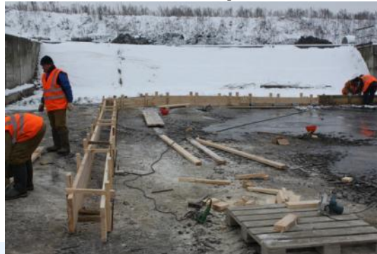
Подготовка дренажной системы для полного сбора и отвода фильтрата
