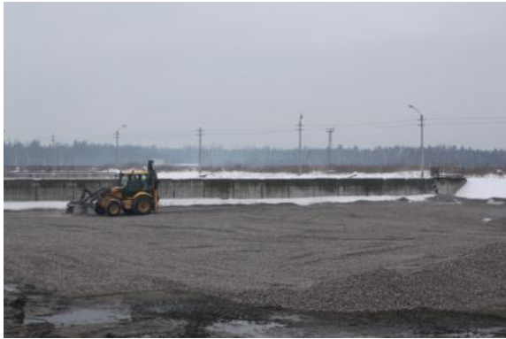
Отсыпка подушка из щебня
