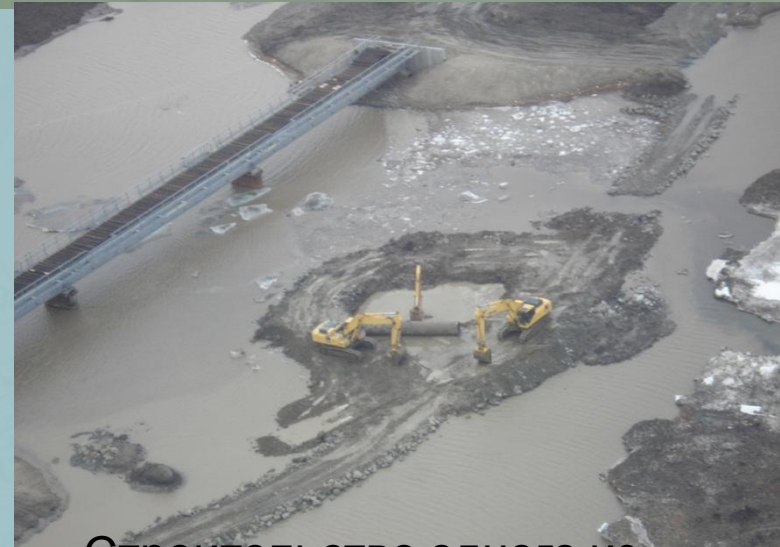
Строительство одного из мостов дороги «Обская-Бованенково»
