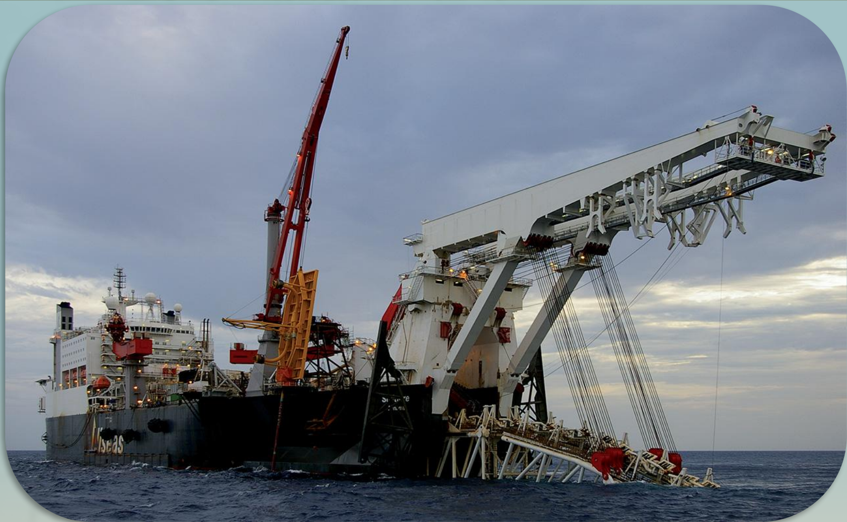
Укладка Северного потока
