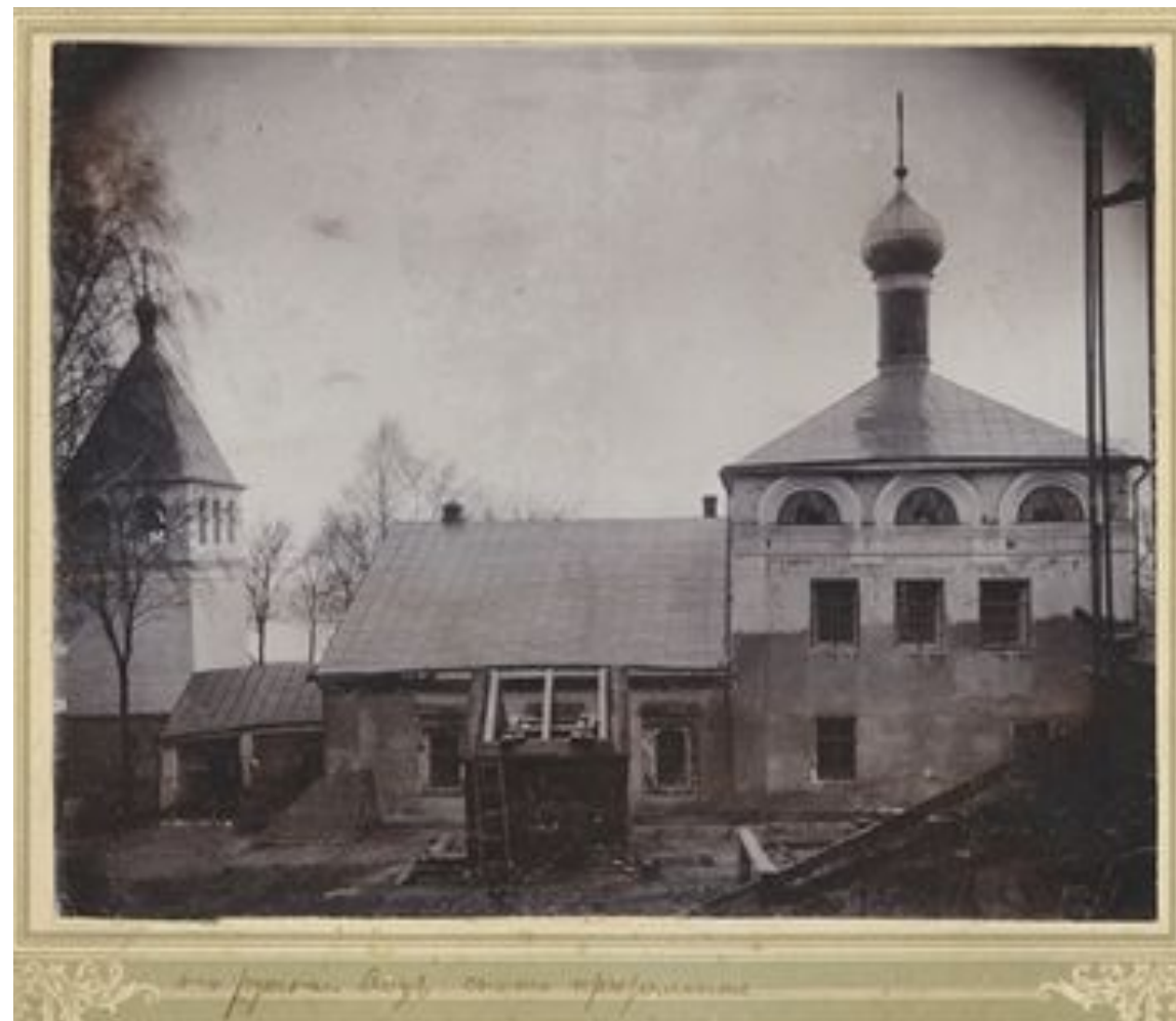
Фото 1912 года, Дудин монастырь. Успенский собор в процессе ремонтно-реставрационных работ. Слева – монастырская колокольня. Фото из личного архива С.Л. Агафонова
