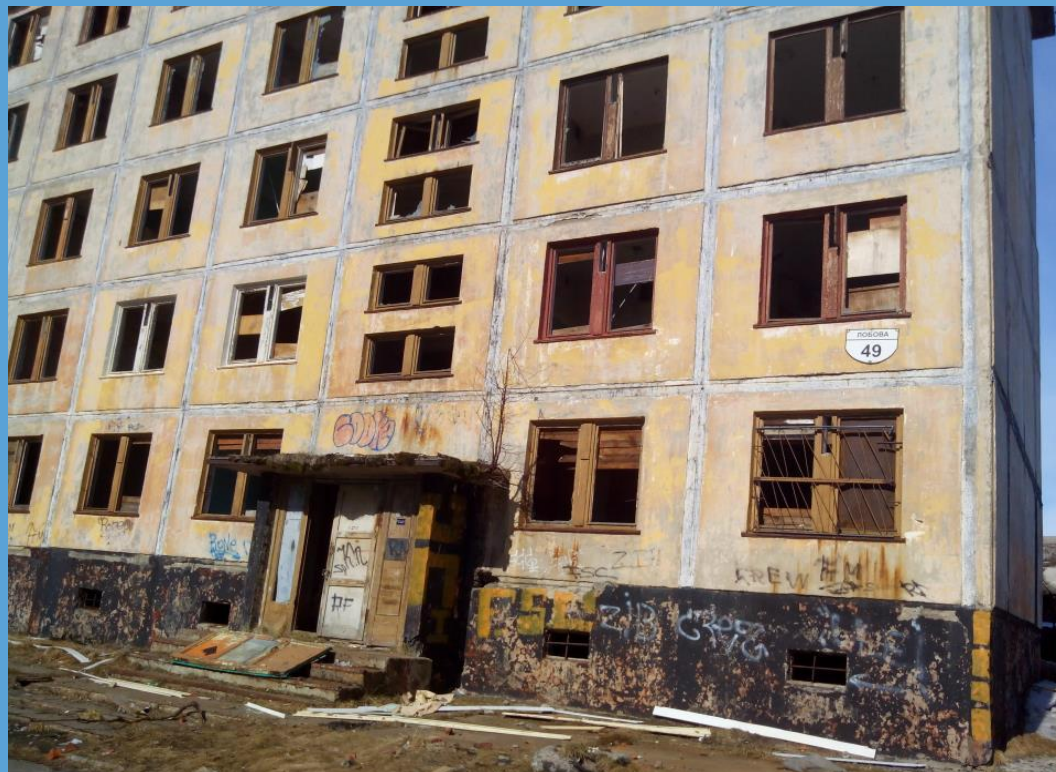
5-ти этажный заброшенный жилой дом. ул. Лобова д. 49. Принадлежит УМС г. Гаджиева 2 СО, стены железобетон, перекрытия железобетон.
