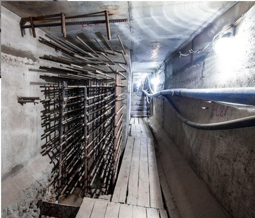
Замораживание ПЛЫВУНОВ
