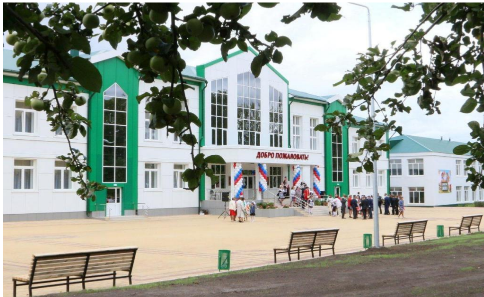
Главный корпус школы на 150 ученических мест в селе Большое Игнатово Большеигнатовского района
