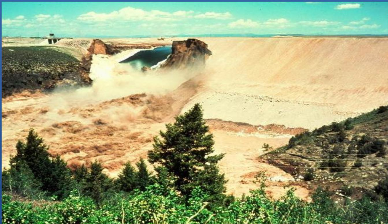
Объем воды и скорость её падения из верхнего бьефа зависит от величины прорана - место повреждения ГОО, через которое устремляется вода из верхнего бьефа при прорыве гидросооружений. Высота, ширина и скорость движения волны прорыва зависит от размеров прорана.
