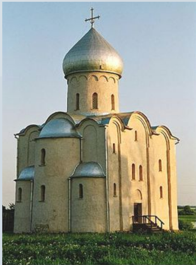
Церковь Спаса на Нередице под Новгородом. 1198.
