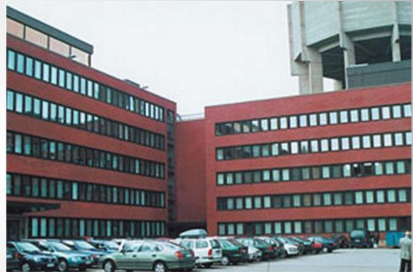
Рисунок 2. Здание «EKONO-house», Финляндия, 1979 г.
