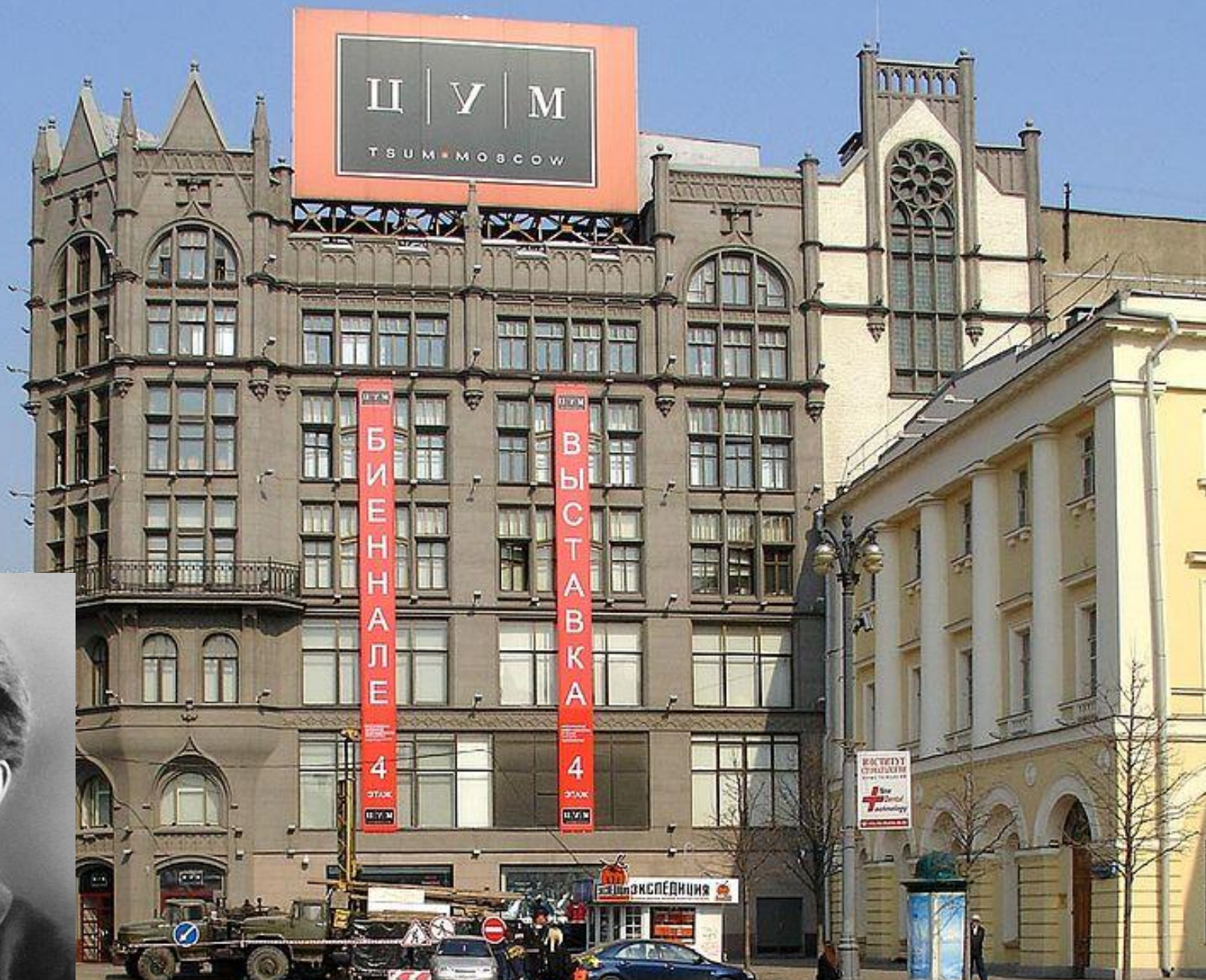
Здание ЦУМ (бывший «Мюр и Мерилиз») на Петровке Арх. Роман Иванович Клейн
