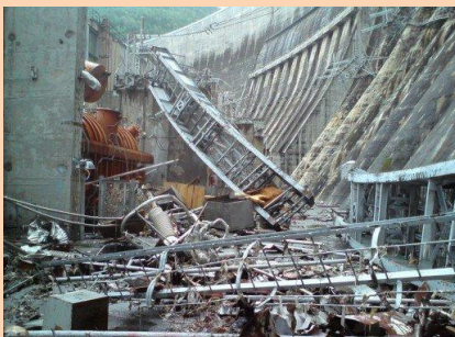
17 августа 2009 г. – авария на Саяно-Шушенской ГЭС.
