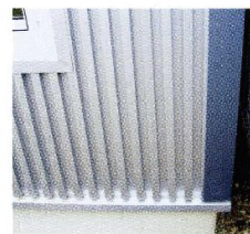
Облицовка из листовой стали с открытыми стыками
