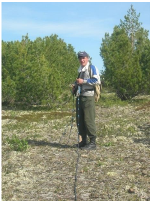
Рис. Установка электрического кабеля (по профилю) при поисковых работах на золото.
