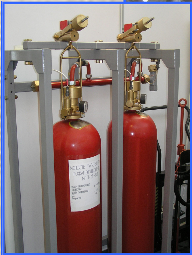
Модуль газового пожежогасіння МГП-2-80 (Харківський механічний завод)
