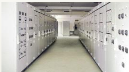
Щиты постоянного тока Приборы и аппаратура для автоматического регулирования, управления
