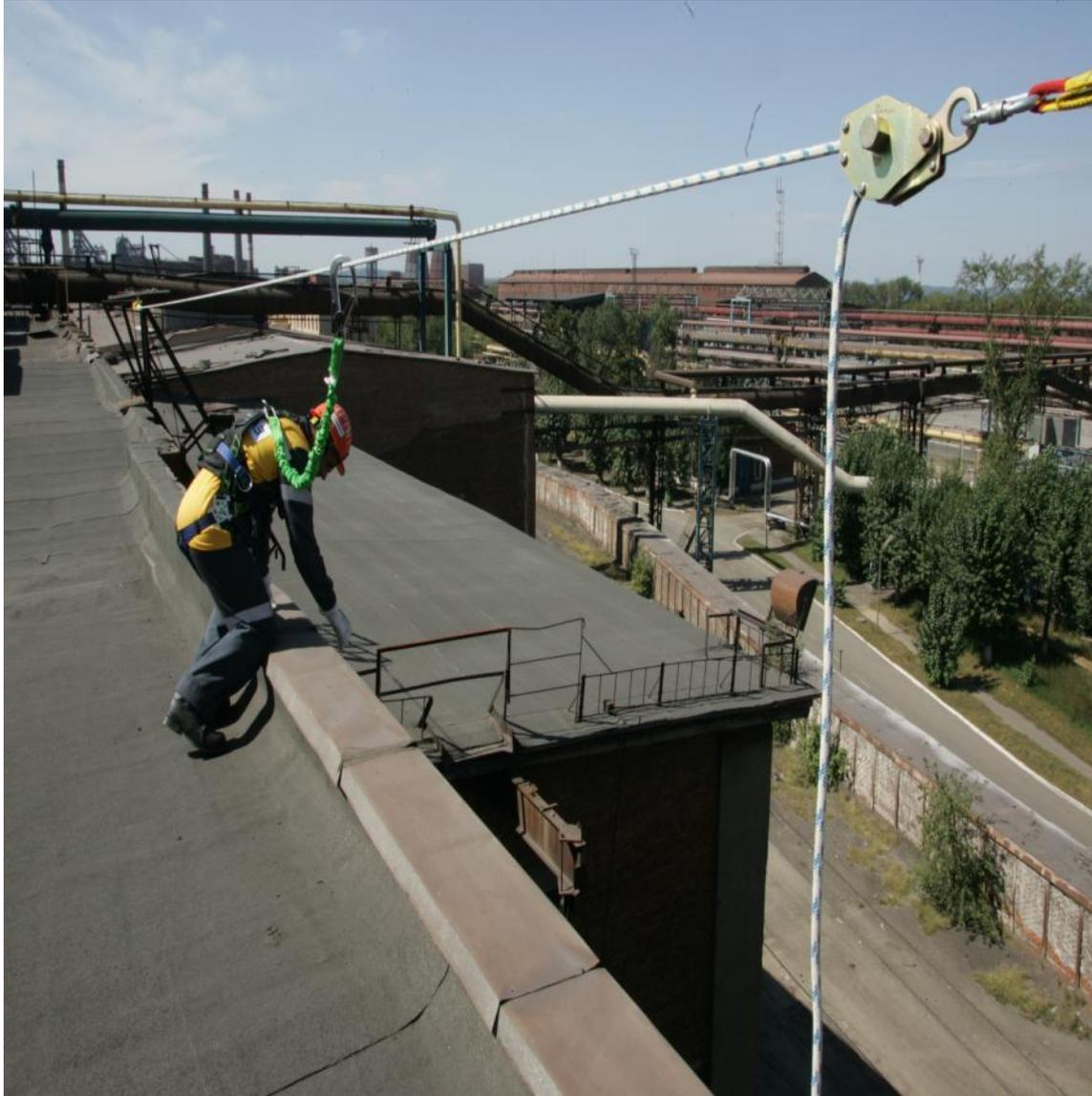
При отсутствии в непосредственной близости от места проведения работ надежных точек крепления рекомендуется применять горизонтальную анкерную линию.
