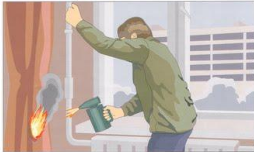
Отогревание замёрзших труб паяльными лампами и факелами
