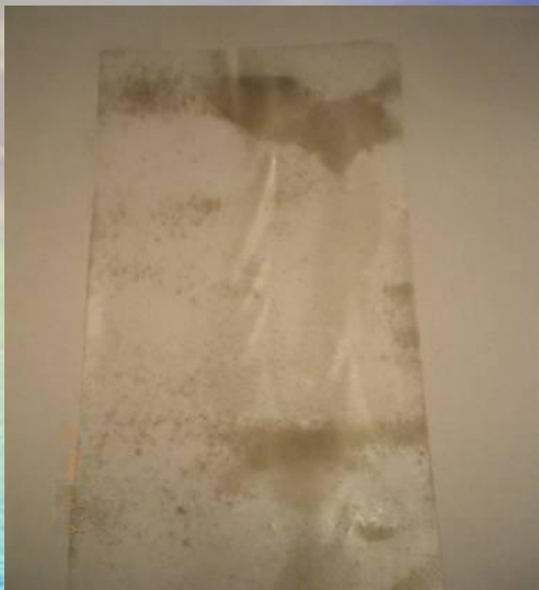
Пыль со шкафа
