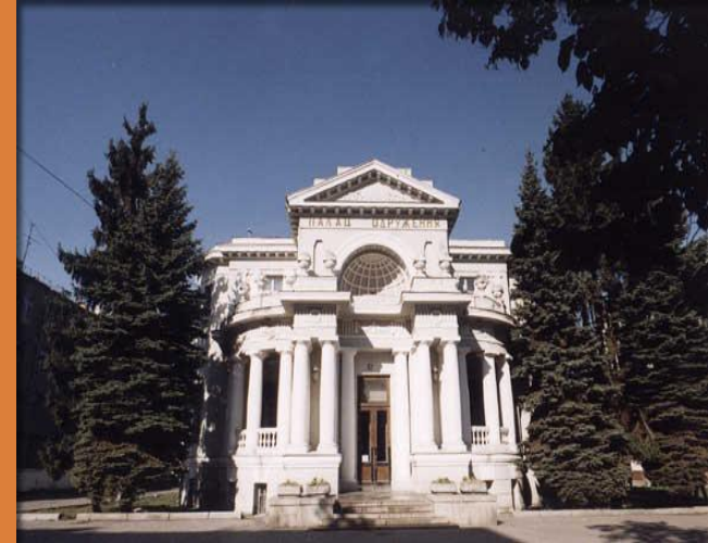
Особняк Юзефовича, ныне – Дворец бракосочетания по ул. Сумской 61, архитектор А.И. Горохов, 1913 г.
