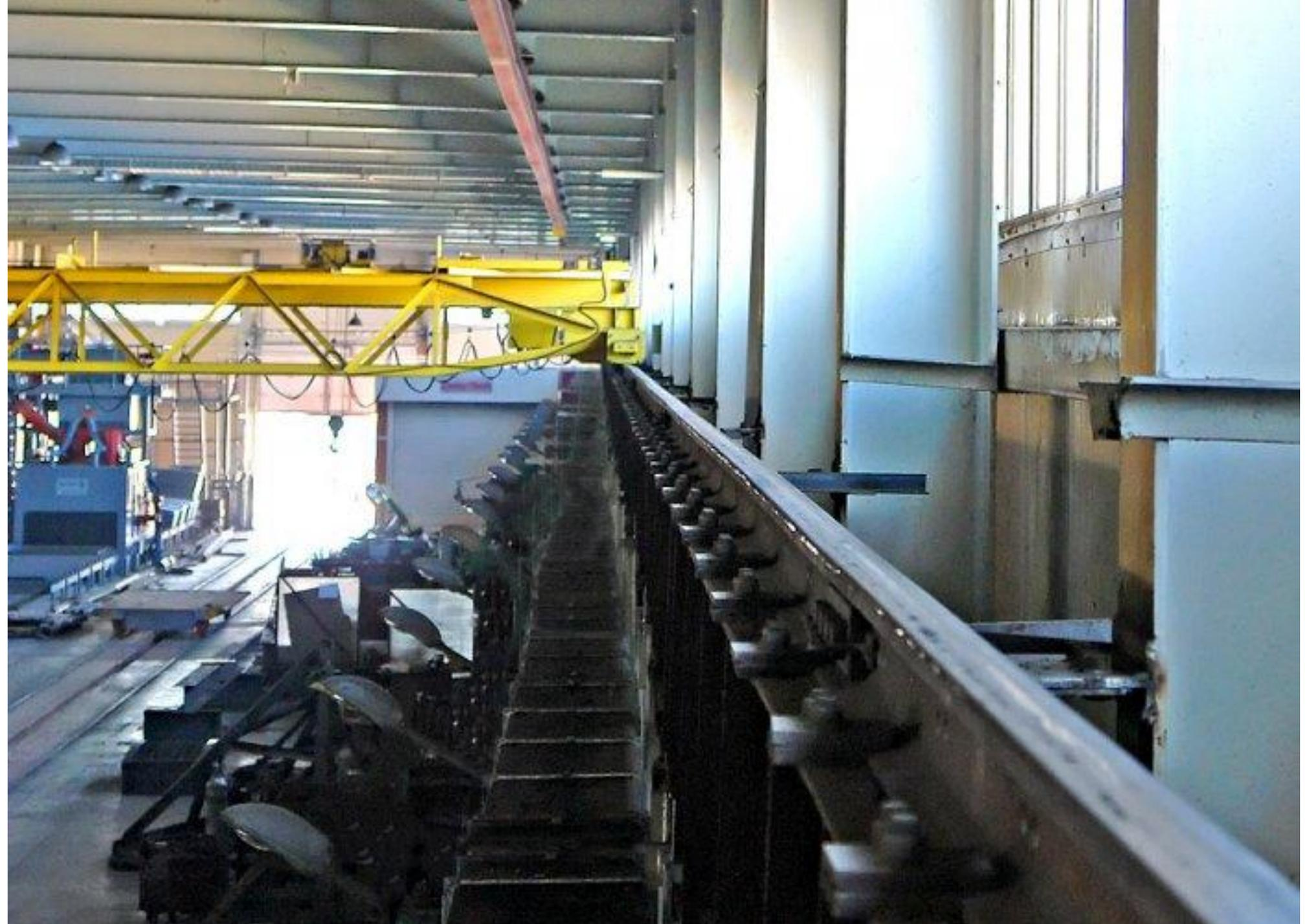
**Подкрановые балки** – это основной несущий элемент крановой конструкции, воспринимающий и передающий крановые нагрузки на неподвижное основание и обеспечивающий безопасную работу крана на всем пути его передвижения. На подкрановой балке находится подкрановый путь.
