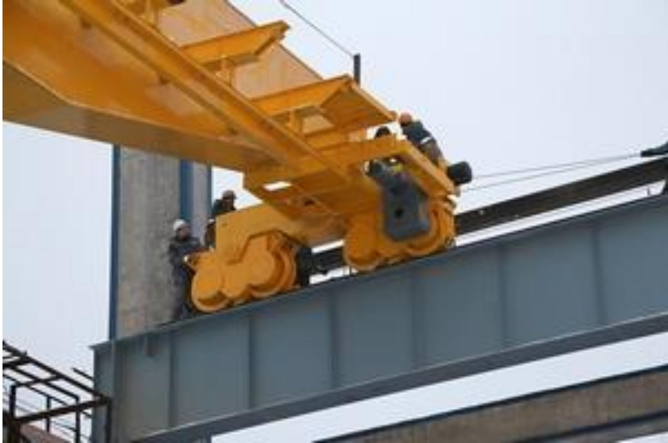
**Крепления рельсов к балкам должны исключать смещение рельсов и должны позволять быструю замену изношенных рельсов. Их концы соединяют двусторонними накладками и болтами или сваривают.**
