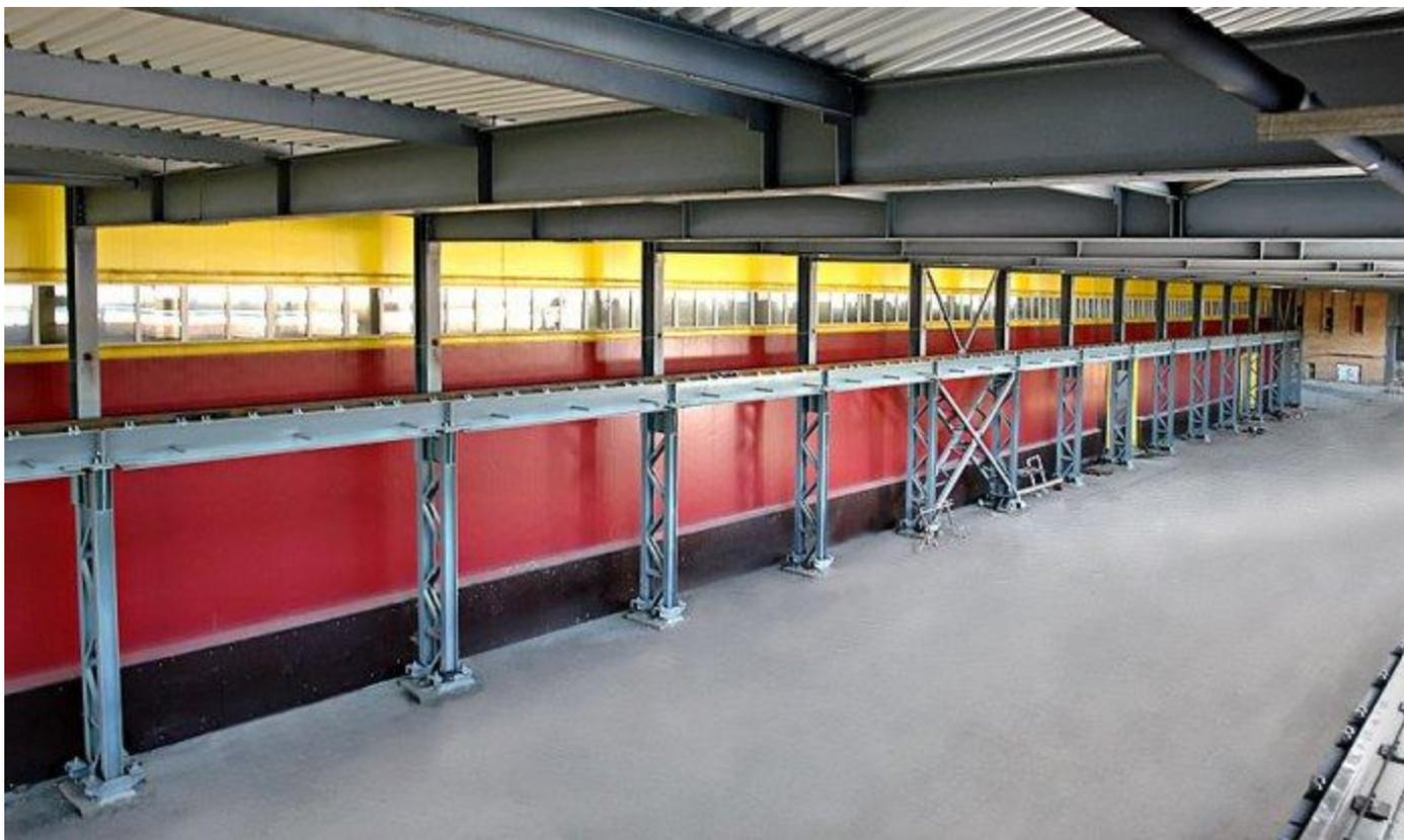
Крановая эстакада встроенного типа используется в производственных помещениях или цехах и устанавливается на опоры. В качестве опор могут быть использованы колонны цеха, на которых и устанавливаются подкрановые балки. Также крановая эстакада может иметь само
