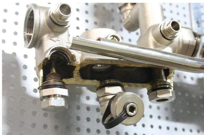
Балансировочно-запорный клапан предназначен для увязки нескольких узлов COMBIMIX (балансировки). Клапан закрыт шестигранным колпачком, поворот клапана осуществляется шестигранным ключом. Положение клапана также можно фиксировать зажимным винтом.
