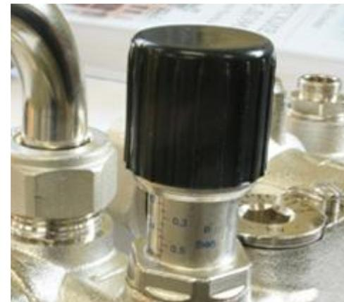
Предназначен для предохранения насоса от режима, при котором отсутствует проток жидкости через насос. Клапан срабатывает на определённый перепад давления, который задаётся поворотом ручки. Сбоку клапана есть удобная шкала с диапазоном значений от 0,2-0,6 бар.
