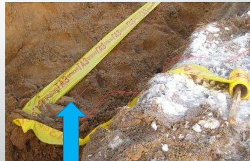
На участках открытой прокладки газопровода предусмотрена укладка сигнальной ленты на расстоянии 0,2 м от верха газопровода
