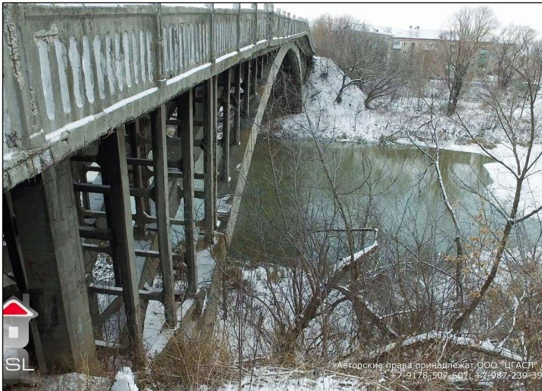
Горбатый мост - железобетонная конструкция длиной 65 метров, которая соединяет ул. Табейкина и ул. Ивлина. Построен мост в начале 20 века, в данное время движение по нему закрыто (даже пешеходное), так как он находится в аварийном состоянии
