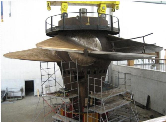
Рабочее колесо поворотно-лопастной турбины
