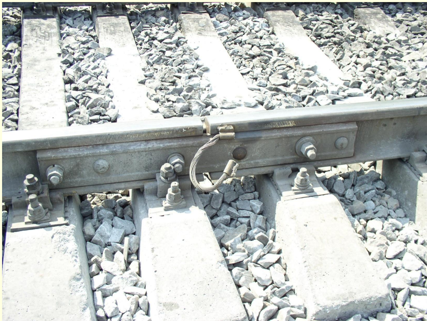
Неисправный стыковой соединитель
