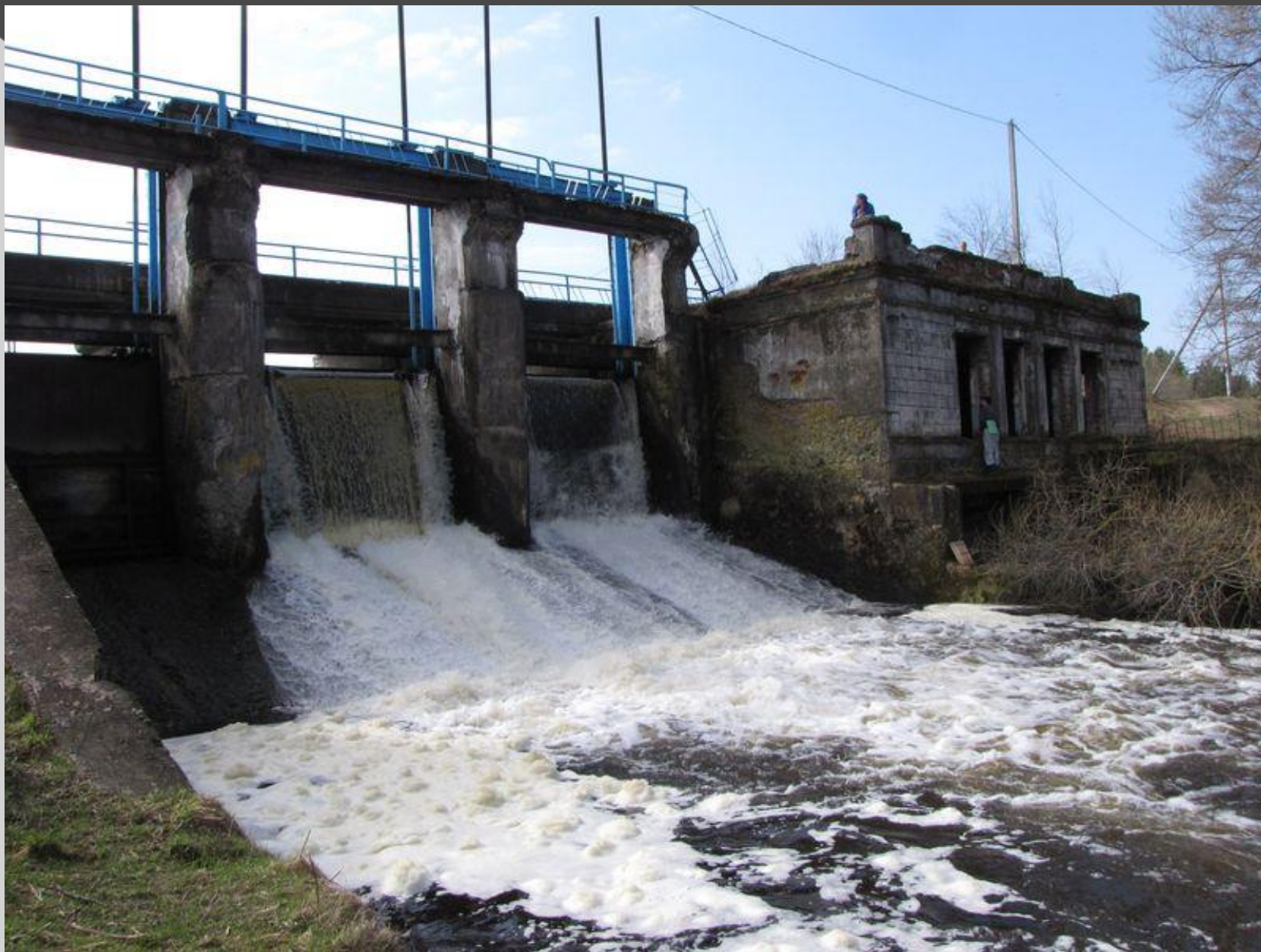
Рис. 12. Сброс воды через плотину
