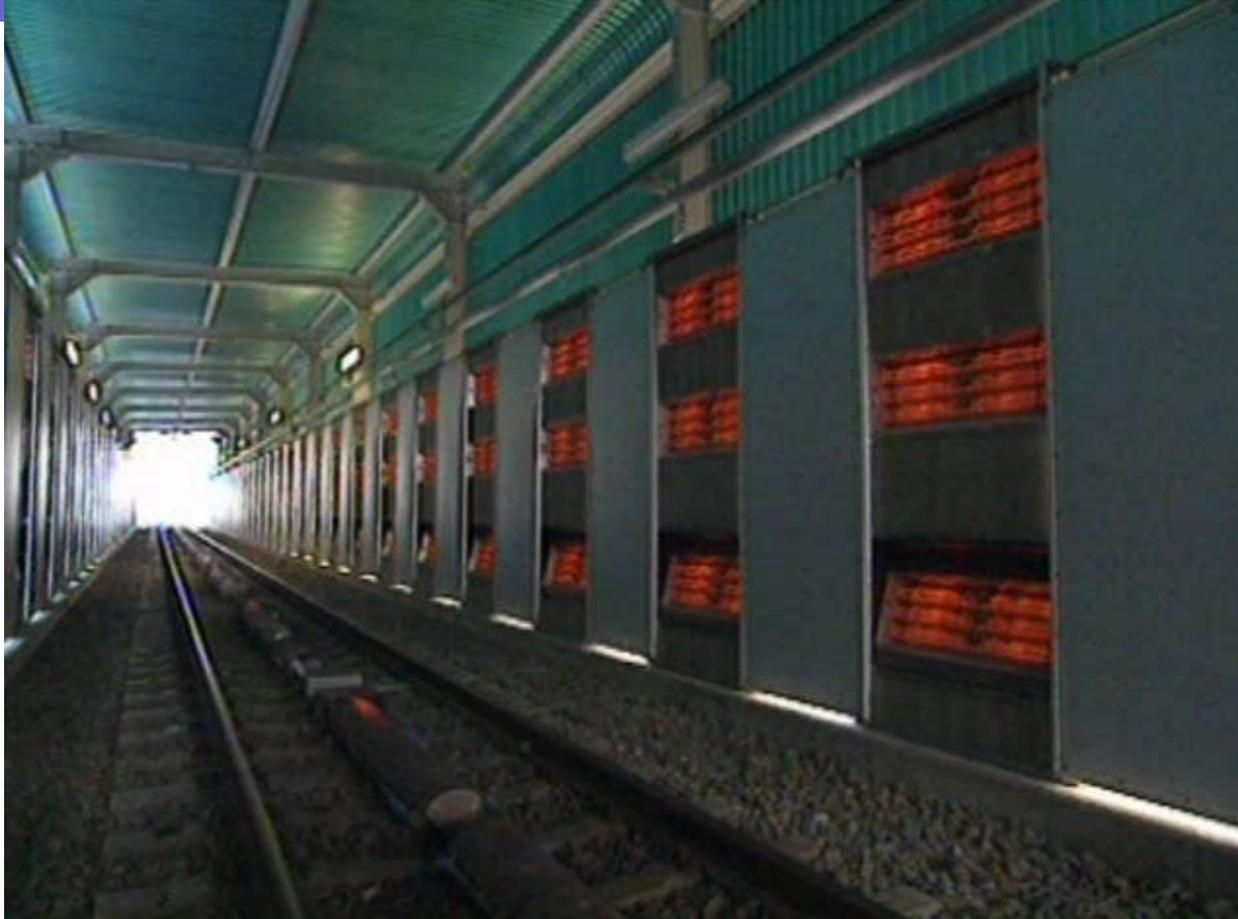
Размораживание вагонов: эл. и газовый обогрев
