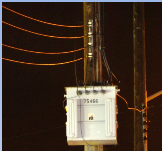
Трансформатор на линии электропередач
