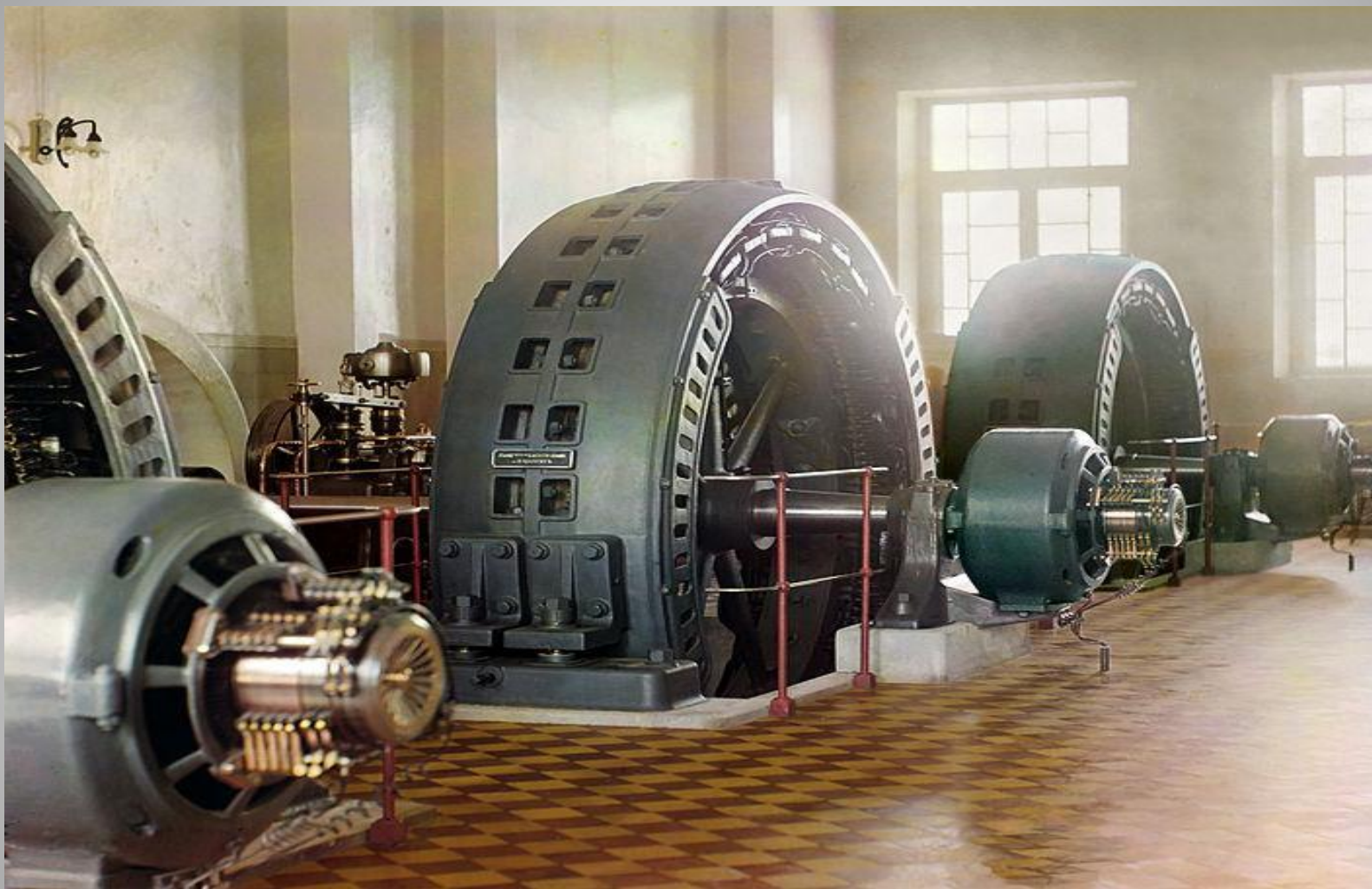
Генератор переменного тока начала 20-го века сделанный в Будапеште, Венгрия, в зале производства электроэнергии гидроэлектростанции (фотография Прокудина-Горского, 1905—1915).
