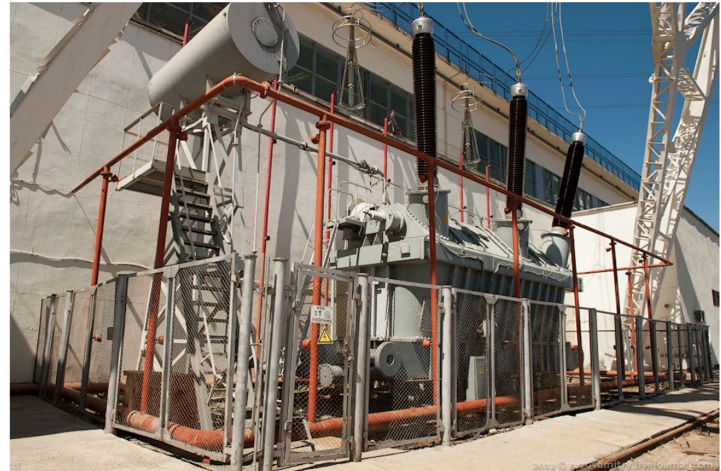
Трансформатор 13,8 / 500 кВ
