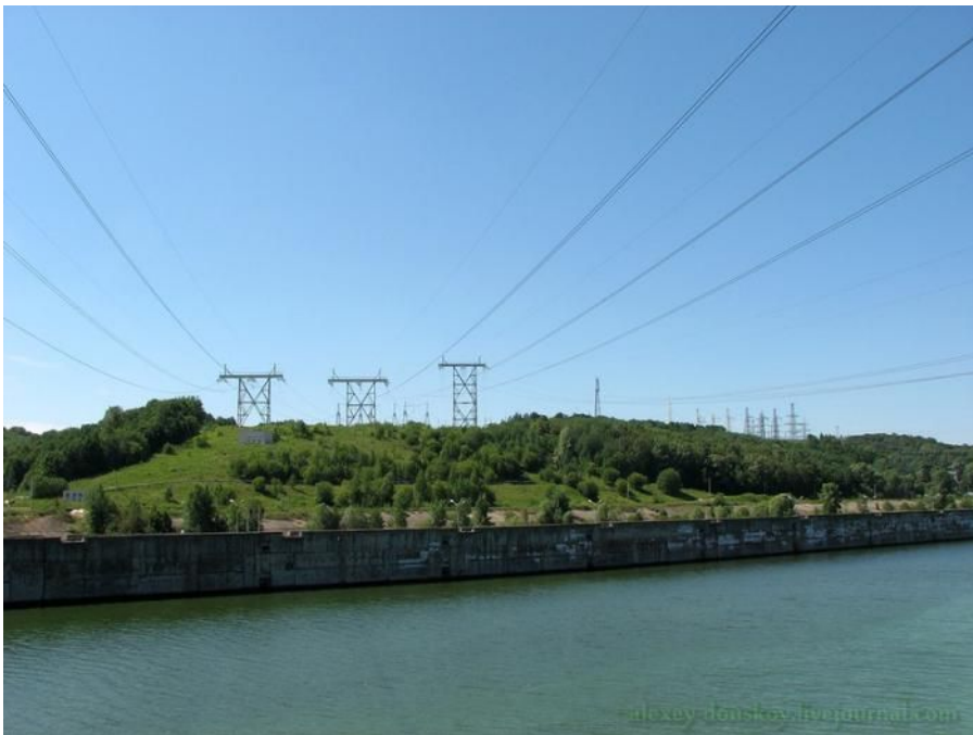
ЛЭП Чебоксарской ГЭС
