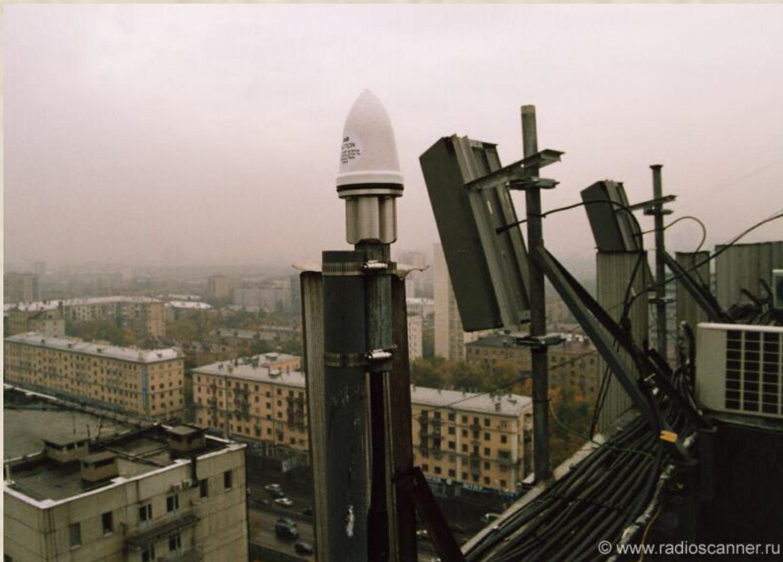
**Рис.30 - Приемная антенна *GPS* для синхронизации времени б/с сети *Satlink* (CDMA-450).**
