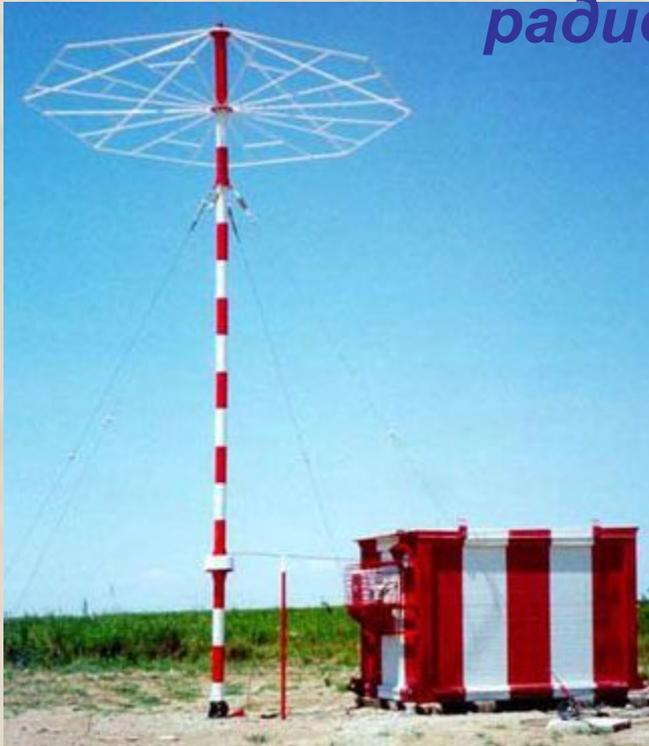
*Рис.3 – Антенна зонтичного типа АЗМ, диапазон частот 190-1750 КГц*
