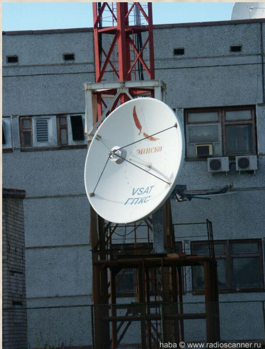
**Рис.28 - Антенна спутниковой связи VSAT.**
