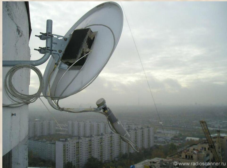
**Рис.42 - Оффсетная антенна РРС типа «Астра», 11 ГГц, *Ethernet* (или поток E1/E2). Москва.**
