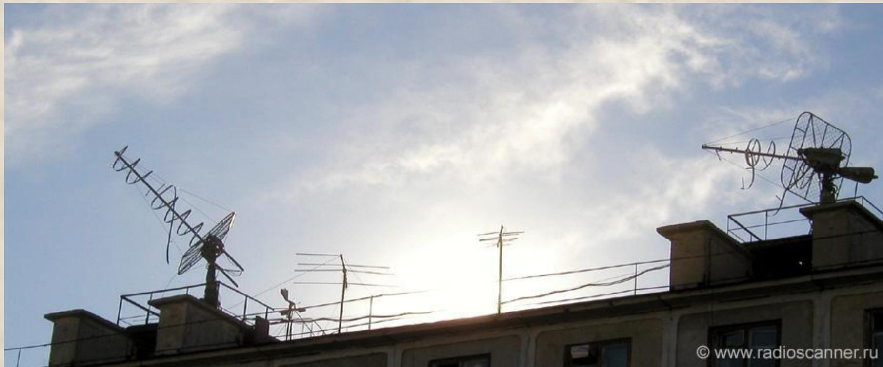
***Рис.27 - Антенны для приема метеоданных со спутников***
