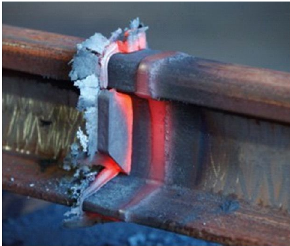
Использование термитных материалов в качестве сварки для рельсов
