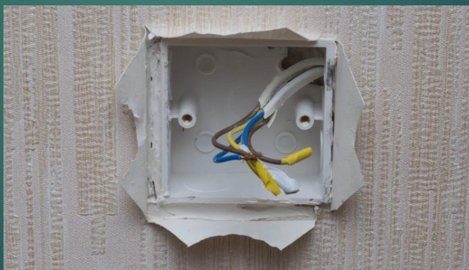
3) Устанавливаем подрозетник
