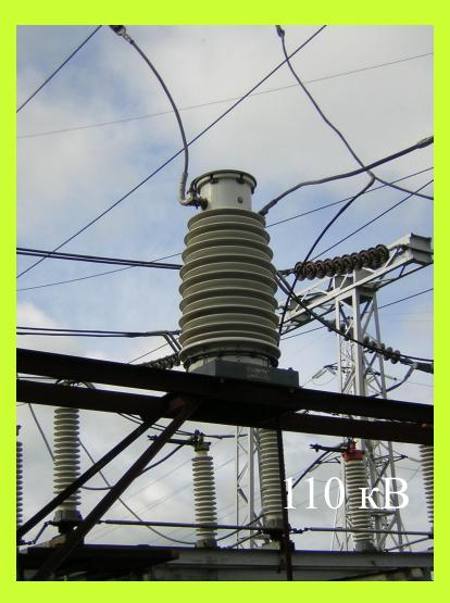
**Распределительным устройством РУ** называется электроустановка, которая служит для приема и распределения электрической энергии между потребителями.
