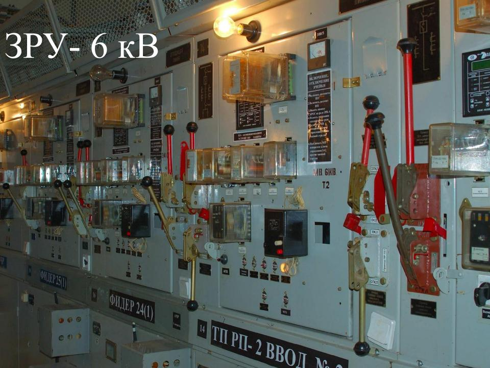
**Выключатель** – электрический аппарат, предназначенный для разрыва цепи тока *(тока нагрузки или тока короткого замыкания)*
