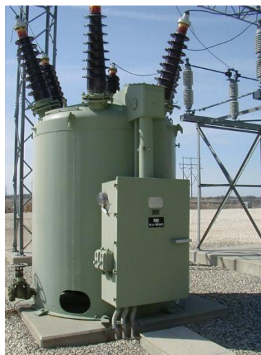
Баковый масляный выключатель
