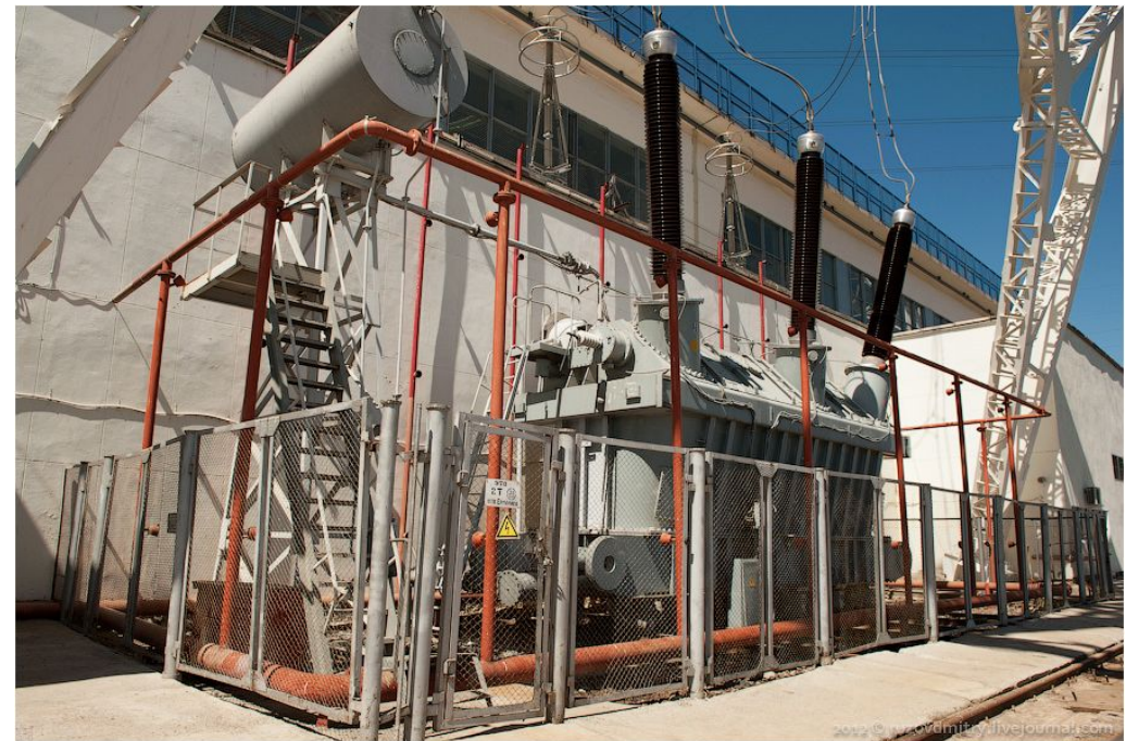
Трансформатор 13,8 / 500 кВ
