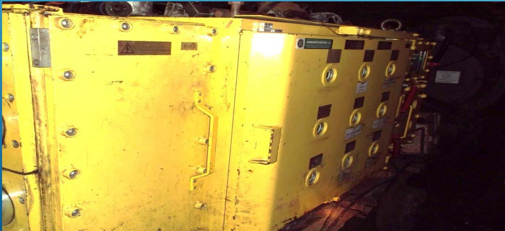
Станция может быть оборудована тремя токовыми линиями и блоком трансформатора 6,3 кВА.
