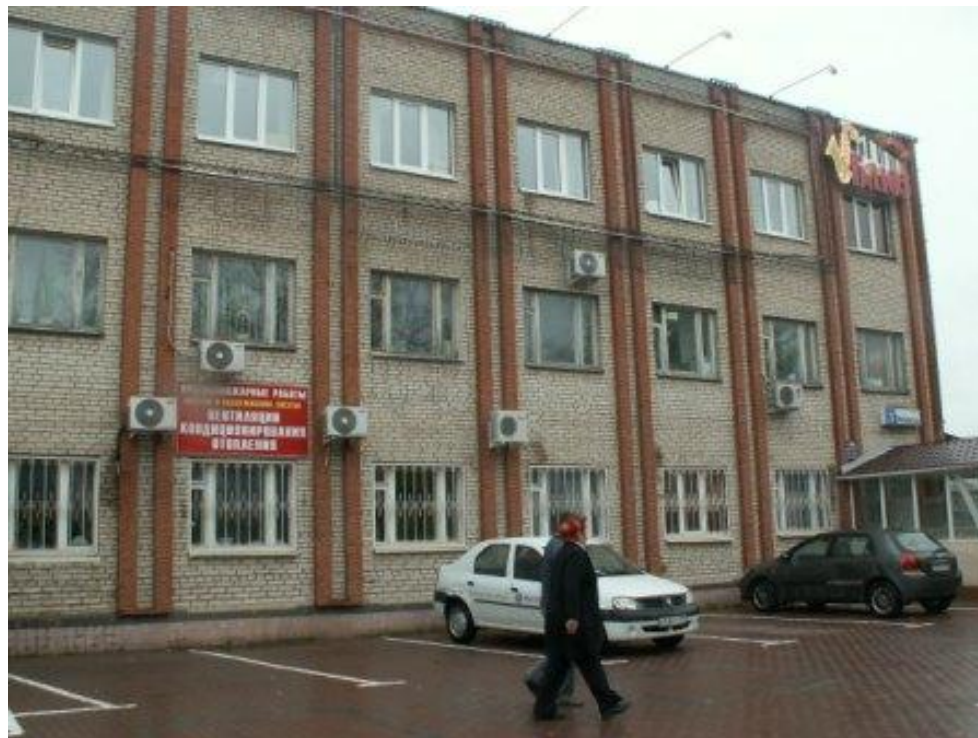
Фото. 1. Вид объекта под размещение БС
