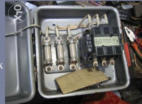
4. Контактёр - аппарат задействованный для многочисленных операций включения и отключения цепи с рабочим током или немного большим
