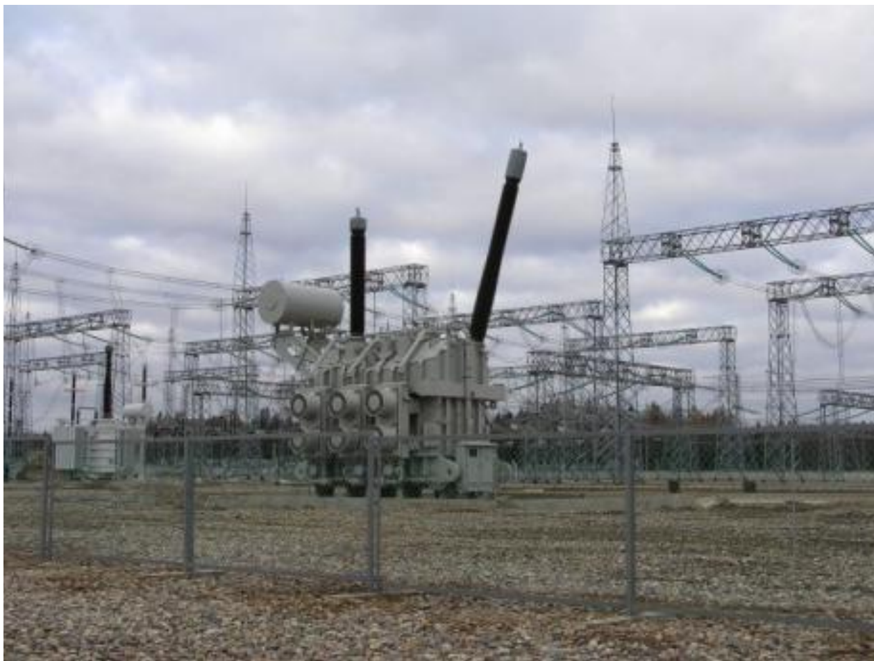
Однофазный АТ 750/500 кВ трехфазной группы 3x417 МВА
