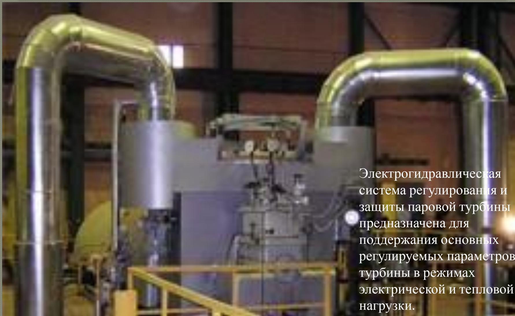
Электрогидравлическая система регулирования и защиты паровой турбины предназначена для поддержания основных регулируемых параметров турбины в режимах электрической и тепловой нагрузки.
