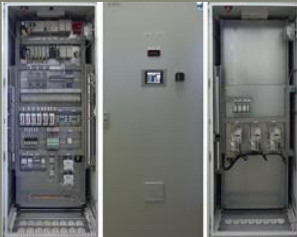
Шкаф бесперебойного питания ( $\sim 220\text{В}$ -основной ввод,  $=220\text{В}$ -резервный ввод).
