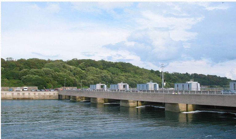
ПЭС «Ля Ранс» Франция 240 МВт
