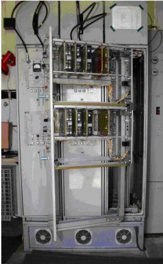
Рис.10. Шкаф синхронизации и сопряжения в выдвинутом положении
