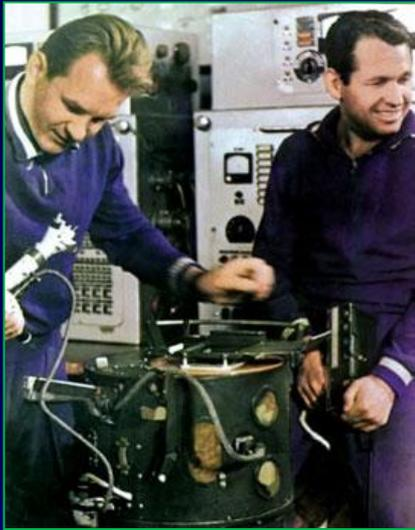
16 октября 1969 г. летчики-космонавты В.Н. Кубасов и Г. С. Шонин впервые осуществили *автоматическую сварку и резку* на корабле «Союз-6» с использованием установки «Вулкан». Установка позволяла в автоматическом режиме выполнять дуговую, плазменную и электронно-лучевую сварку.
