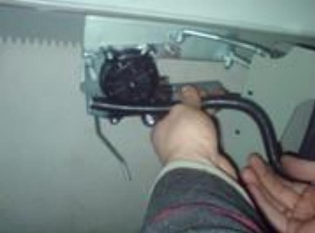
После окончательной настройки и регулировки ЭПД закрепить прилагающимися в комплекте винтами декоративную крышку двигателя ЭПД в порядке указанна на рисунках
