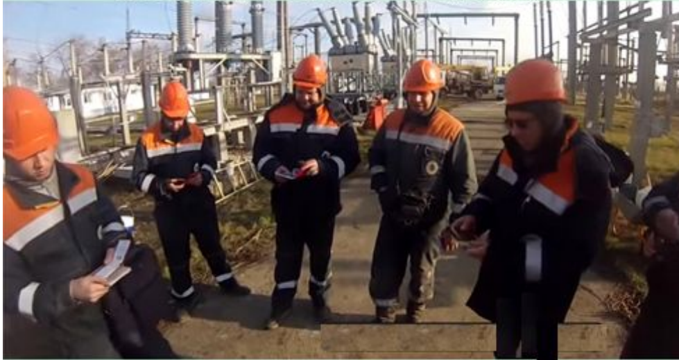
Проверка удостоверений у бригады при допуске
