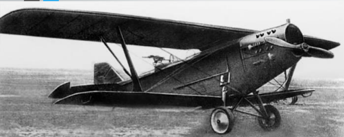
Разведчик Р-3 с мотором «Лорэн-Дитрих»
