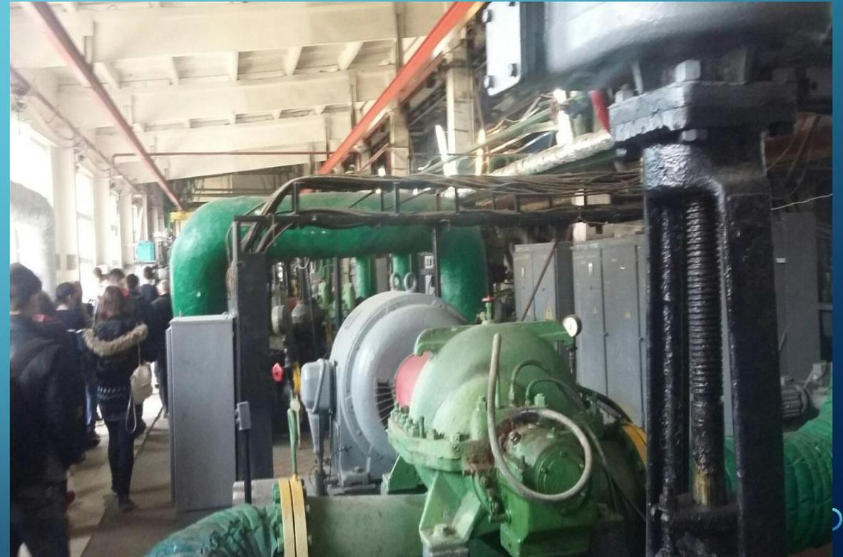
Сетевой трубопровод на выходе из котельной с показывающими манометрами
