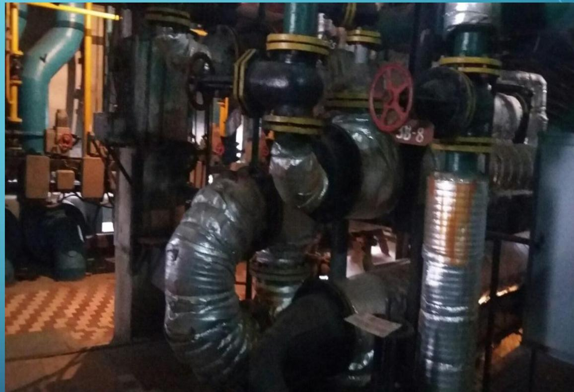
Вентиляторы с воздуховодами котла (для каждой горелки свой вентилятор, для котла ПТВМ-50 всего 10 горелок на 5 шт с каждой стороны)
