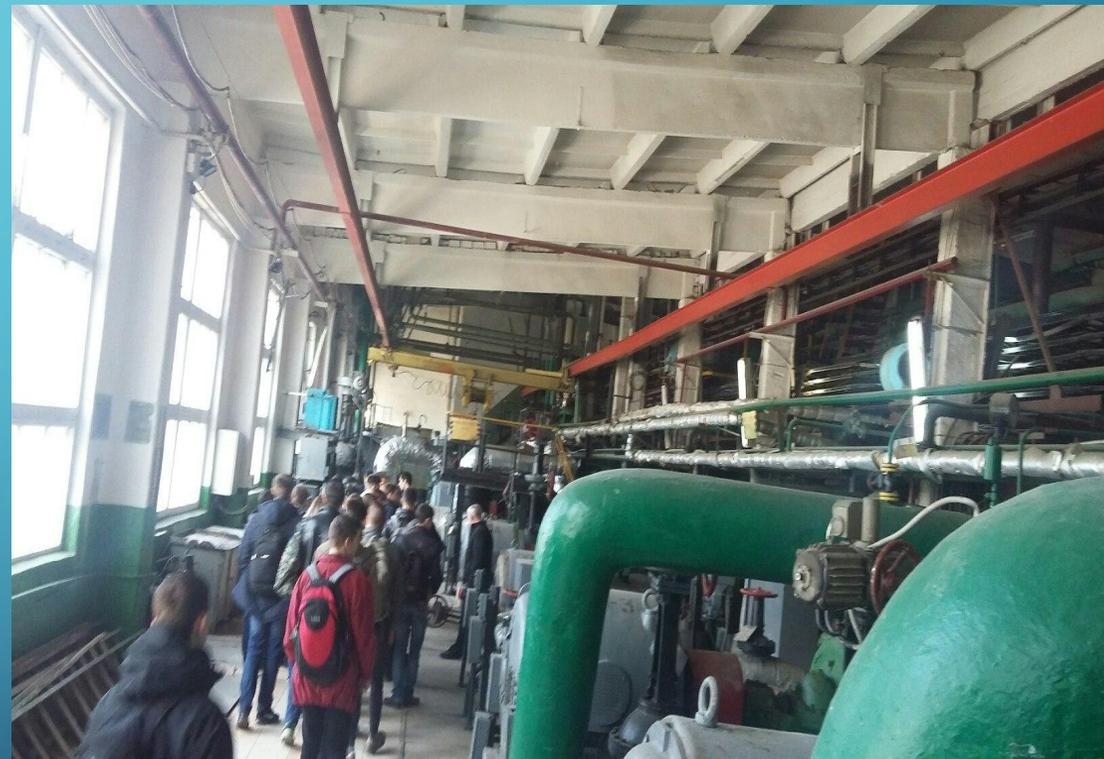
Деаэрационный бак покрытый теплоизоляционной краской
