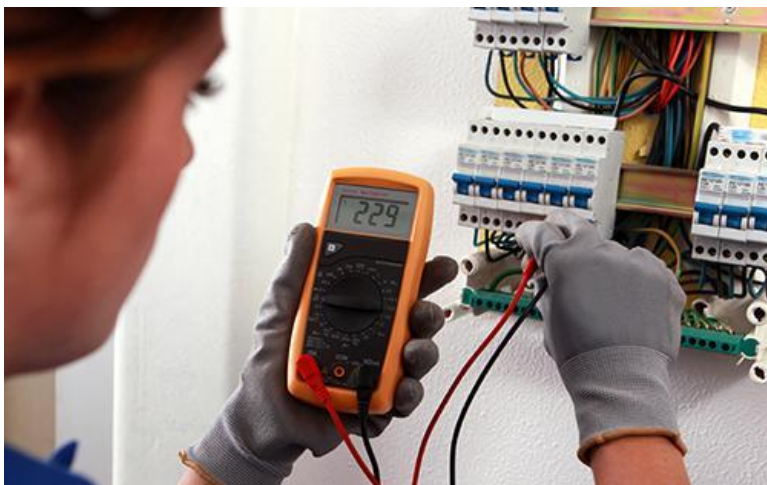
проверка сопротивления изоляционного слоя;
